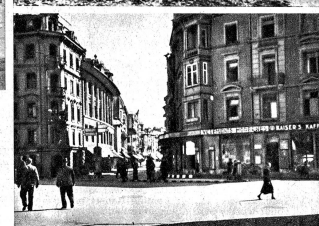
Alle Mühlebrücke. Heute sind nicht mehr viel Spuren der alten Mühlebrücke vorhanden
