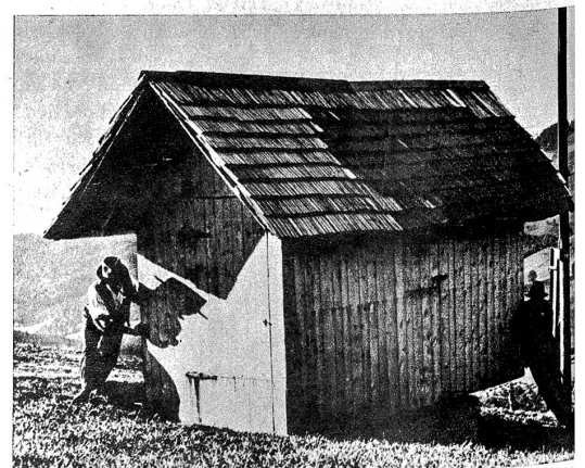
Auf halber Höhe des Schindelbergs steht das von den Genossenschaftlern gemeinsam erbaute Maschinenhaus mit Motor und Seilwinde. Ein einfacher, von den Bauern selbst angeregter Mechanismus erlaubt die beliebige Drehung des Hauses und ermöglicht die Verwendung der Seilwinde in jeder Richtung
