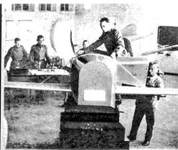
**Ausbildung im „Linktrainer“.** Hier erlernt der Pilotenschüler das Fliegen nach den Bordinstrumenten, den sogenannten Blindflug. Obschon er in zugedeckter Kabine „fliegt“, kann er vom Fluglehrer genau kontrolliert werden. Am Kommandostisch wird auf einem Blatt der „Flieger“ automatisch aufgetragen. Befehle und Weisungen werden dem Schüler in Telefonie oder Telegrafie übermittelt.
