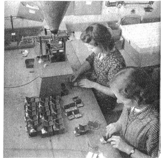
Automatische Verpackung der Grammophonadeln
