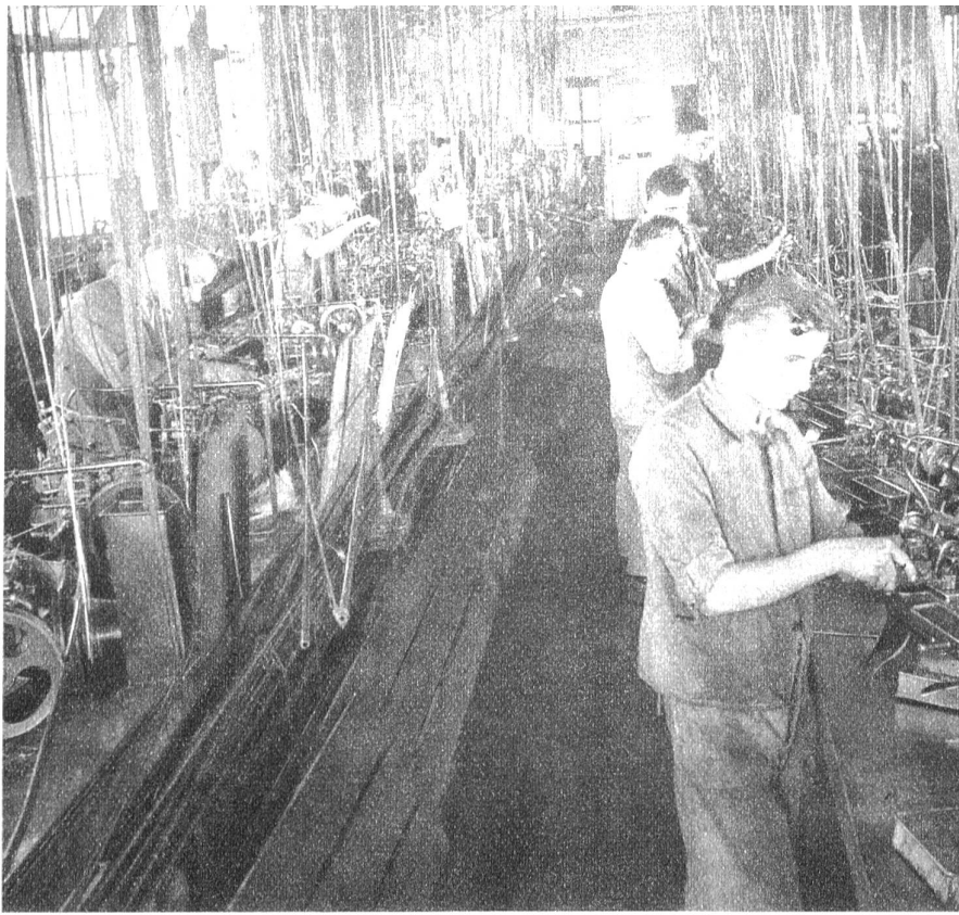
Teilansicht der Maschinenhalle für Uhrenbestandteile. Automaten mit Transmissionsantrieb
