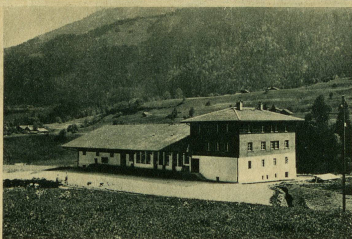
Das neue Abfüll- und Lagerhaus in Weissenburg
