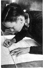
Die Bauteile werden vom Bauplan auf das Sperrholz durchgepaust
