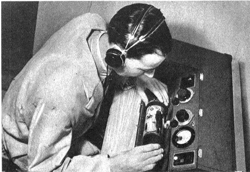
Empfangs- und Sendeapparatur für radiotelegraphische Bildübermittlung in der Schweiz. Eine photographische Aufnahme wird auf die drehbare Walze aufgespannt. Die erste photographische Aufnahme aus der Schweiz wurde am 8. März 1943 durch die Photo-press ausgestrahlt. Sie wurde in 20 Minuten von der Schweiz nach den USA übertragen
