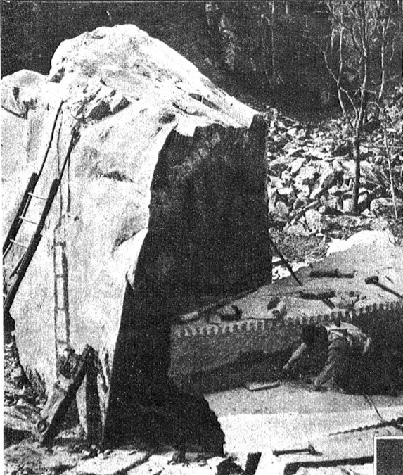
In den Steinbrüchen von Osogna im Tessin sind verschiedene Steinblöcke für die Schaffung des Bunderat-Molta-Denkmal gebrochen worden. Ein Block von 400 Doppelzentner und 5 m Höhe ist freigelegt worden
