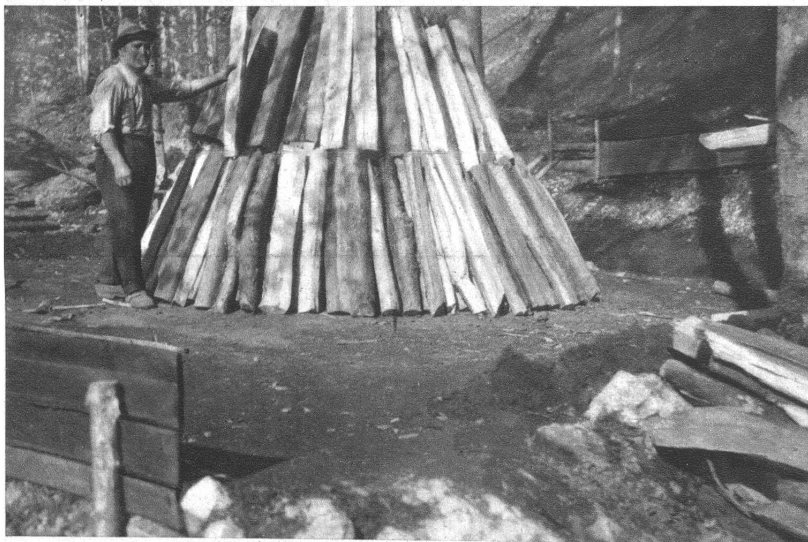
Der Meiler im Rohaufbau mit dem ebenen Untergrund
