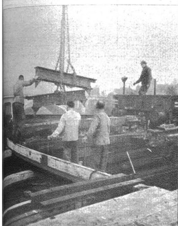
Die bereitgestellten Loris nehmen das Altmaterial auf, um es der neuen Bestimmung zuzuführen.
