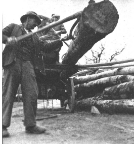
Das Rohmaterial. Buchenstämme werden abgeladen.
