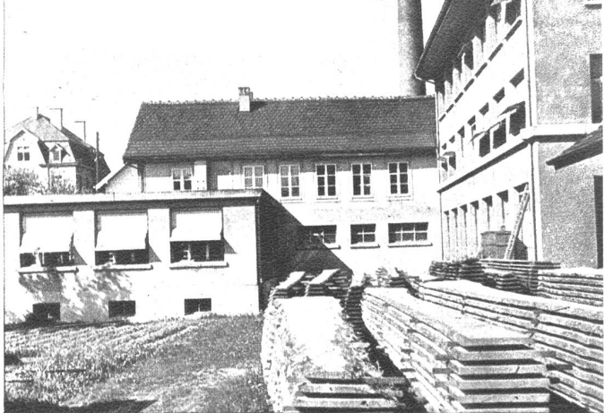
Die moderne Fabrikanlage mit allen notwendigen maschinellen Einrichtungen fortgeschrittener Produktionstechnik.
