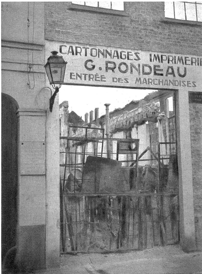
Blick in das Innere einer von Brandbomben zerstörten Fabrik. Das ehemalige Fabrikator ist mit allen möglichen Eisentrümmern verbarrikiert. In Calais-Nord begegnete ich nur selten einem Gebäude, das noch so „wohl erhalten“ war, von dem noch so viele Steine aufeinander standen.
