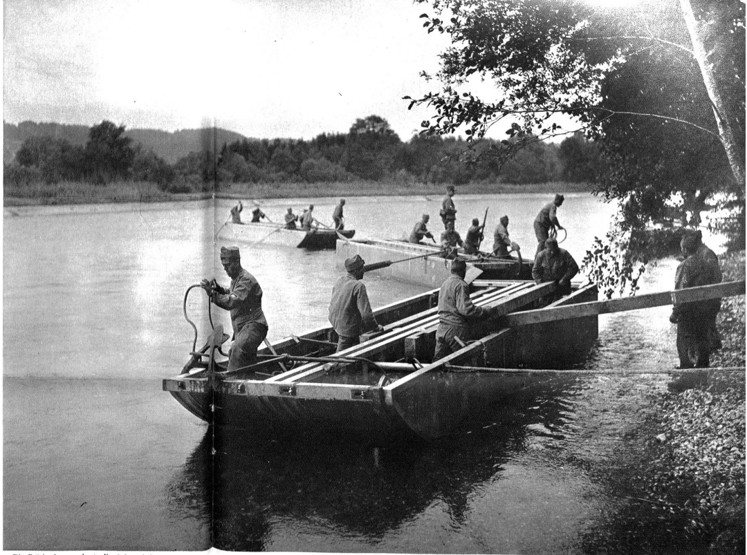
Die Brücke ist ausgebaut, die Anker sind gelichtet worden und es werden jetzt die Schiffe ans Ufer gefahren, um abgerüstet zu werden.
