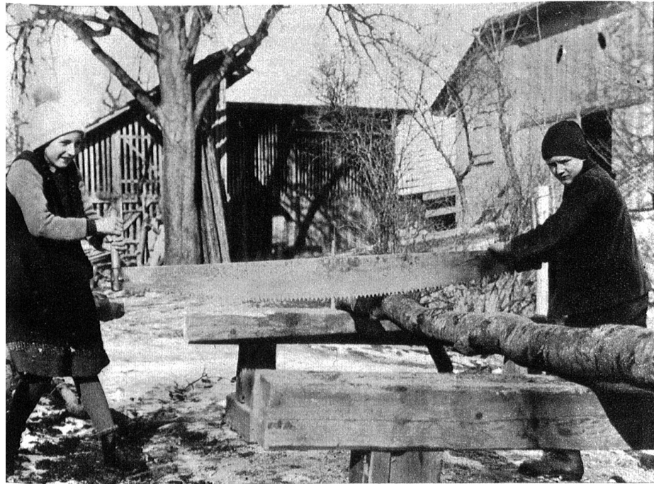
Das Sägen mit der Waldsäge ist gar nicht so schwer. Nur das Blatt richtig führen, damit es nicht klemmt!
