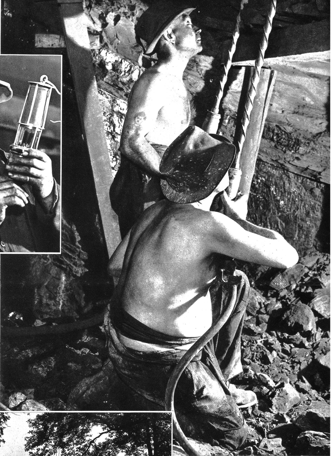
Bergmänner beim Gesteinbohren
