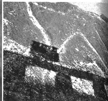
Der Schatten der Bahn
