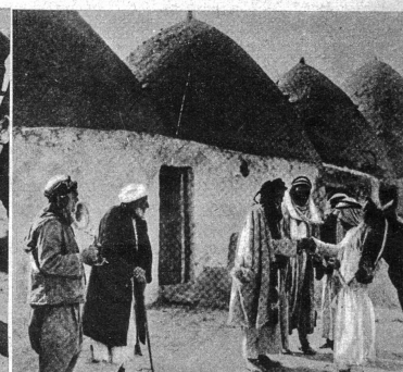
In Nordsyrien stehen diese Dörfer der bienenkorbbähnlichen Häuser. Diese Bauart kommt nicht von ungefähr, sondern ist die Folge des Holz mangels — so ist man auf diese Kuppelform gekommen. Bei langen Regenfällen stürzen viele dieser Kuppeln ein und dann spricht man in europäischen Zeitungen von «vernichtenden Hochwassern und dem Verluste von so und so vielen Dörfern»
