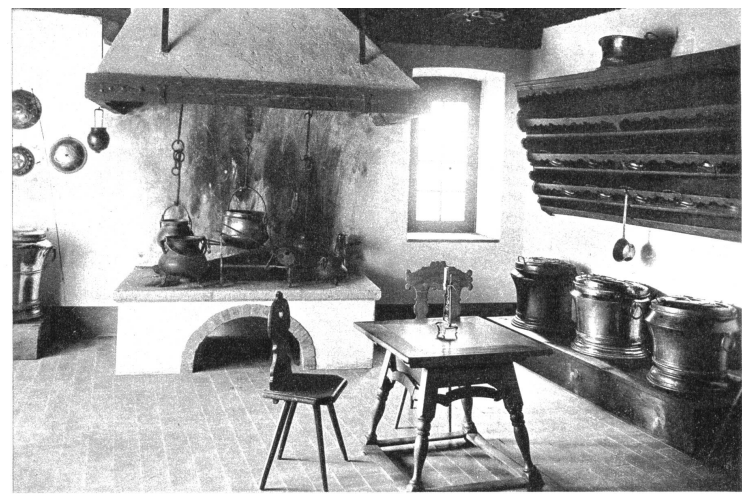
Die geräumige Küche, die zugleich als Essraum für die Dienerschaft, vielleicht sogar für die Familien des Burgherren diente
