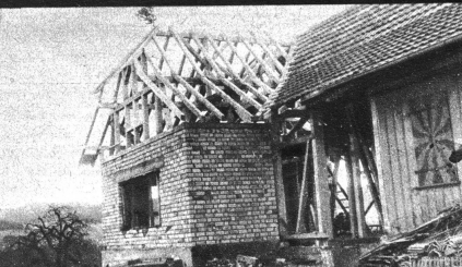
Bald wird auch der Neubau unter Dach sein. Rechts der alte Teil des Schützenhauses
