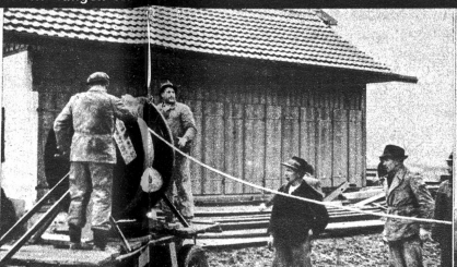
Zu einer interessanten Arbeit gestaltete sich die Legung des 300 m langen Kabes vom Schützenhaus zum Scheibenstand
