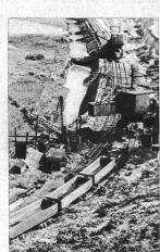
Die Gewinnung von Oelschiefer entlang den Ostseeküsten ist ein altes Gewerbe und wird heufe maschinell betrieben. Oelschiefer wird zur Oelgewinnung gebrochen
