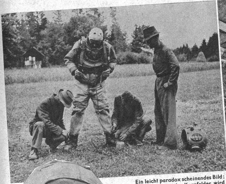
Etwa zwanzig Meter tief geht der Schacht in die Erde, der das Grundwasser sammelt, welches in die Verteilungsstellen der Stadt gepumpt wird. Das Rohr sammelt, welches in die Verteilungsstellen der Stadt gepumpt wird. Nun ist es in der Mitte diente den Arbeitern zum Einstieg in den Caisson. Nun ist es überflüssig geworden und der Taucher muss es auf dem Grunde abschrauben
