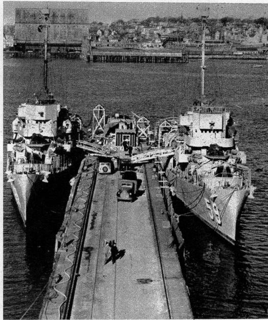
Stromkalamität auch in den USA. Verschiedene Staaten Nordamerikas leiden an Strommangel, da die Flüsse durch anhaltende Trockenheit sehr wenig Wasser führen. Die Stadt Portland hat sich zu helfen gewusst. Man «nahm» zwei Zerstörer, deren Maschinen mit Rohöl versorgt werden und verankerte sie vor einer Landungsbrücke im Hafen. Die Maschinen der beiden Schiffe produzierten genügend Strom, um das Manko der elektrischen Zentrale der Stadt auszufüllen
