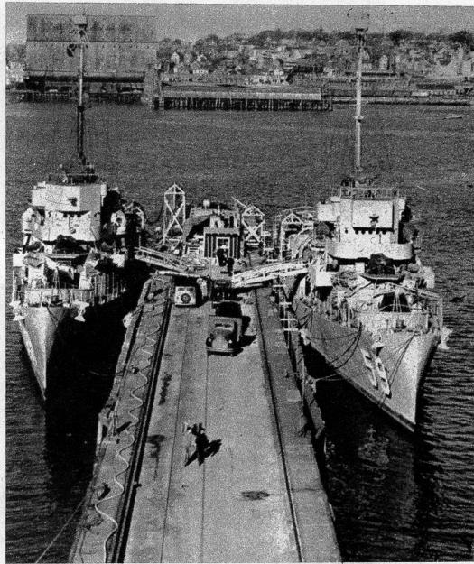
Stromkalamität auch in den USA. Verschiedene Staaten Nordamerikas leiden an Strommangel, da die Flüsse durch anhaltende Trockenheit sehr wenig Wasser führen. Die Stadt Portland hat sich zu helfen gewusst. Man «nahm» zwei Zerstörer, deren Maschinen mit Rohöl versorgt werden und verankerte sie vor einer Landungsbrücke im Hafen. Die Maschinen der beiden Schiffe produzierten genügend Strom, um das Manko der elektrischen Zentrale der Stadt auszufüllen
