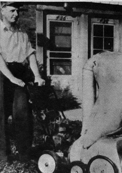
Ein-Mechaniker aus Buffalo hat eine sehr sinnreiche Maschine konstruiert. Mit Hilfe eines kleinen Benzinmotors ist es möglich, die Maschine als Laubsammler zu verwenden. Die zwei rotierenden, mit zahlreichen Stahlborsten versehenen Rollen, die hierzu nötig sind, können in wenigen Sekunden ausgetauscht werden, wonach der Apparat als Schneeschleuder funktioniert. Einige wenige Handgriffe wiederum verwandeln die Maschine in einen hervorragenden Rasenmäher
