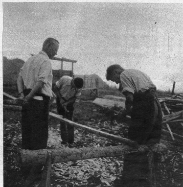
Bergbäuerliche Berufsprüfung im Simmental. Anfertigen eines Dachkanals
