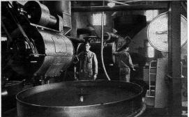
Links: Der fertig geröstete Kaffee strömt aus einer der Rösttrommeln zum Abkühlen
