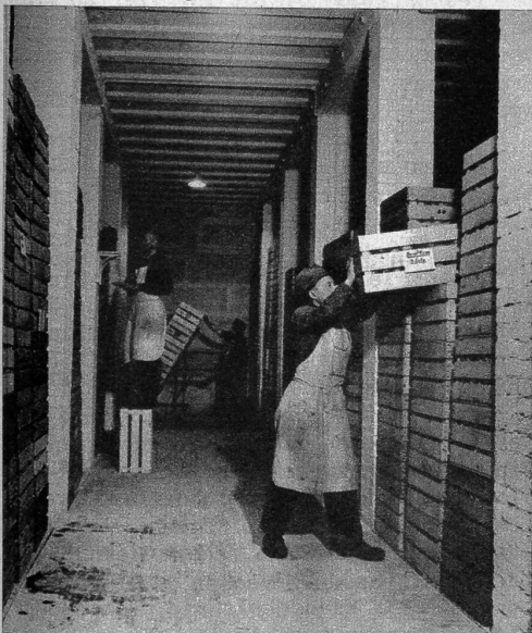
Künstlich ventilierter Obst-Lagerkeller für 120 Tonnen
