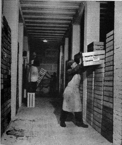
Künstlich ventilierter Obst-Lagerkeller für 120 Tonnen
