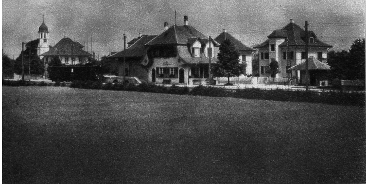
Der Bahnhof von Biberist
