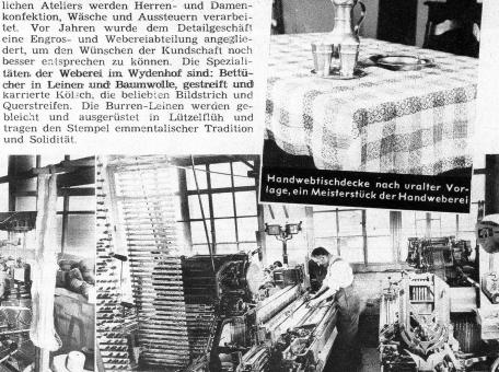
Moderne Bobinen- und Kreuzspulmaschinen präparieren das Garn für Zettelmaschine und Webstuhl. Auf mehrschiffligen Stühlen entstehen die Leinengewebe
