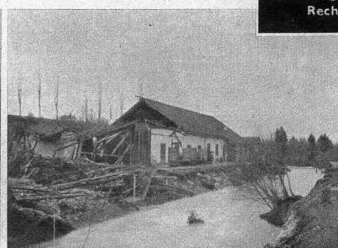
Holzstoff-Fabrik „Hagerhüsli“ nach der Hochwasser-Katastrophe
