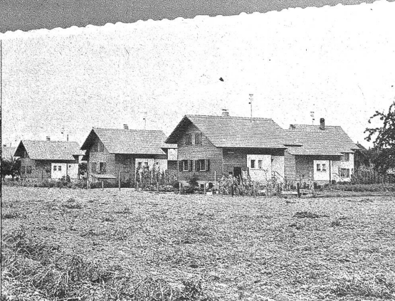
Neue Wohnsiedlung in Oberdorf
