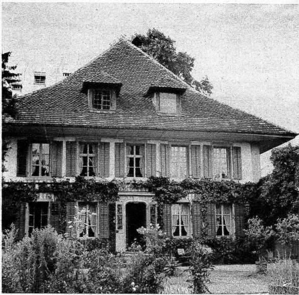
In diesem schönen alten Pfarrhaus hat schon Jeremias Gotthelf einen Teil seiner Jugendjahre verbracht und später als Vikar gewohnt. Dieses wurde in den Jahren 1727/28 erbaut. Dazu gehörte früher ein grosses Pfrundgut, welches durch den Pfarrer bewirtschaftet wurde. 1899 brannte die Pfrundscheune vollständig ab und wurde nicht wieder aufgebaut (Photos Hugo Frutig)
