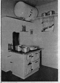
sauber wie ein elektrischer Herd. Der Wunsch jeder Hausfrau, eine ständige Heisswasserquelle in Küche und Badzimmer zu besitzen, geht in Erfüllung durch Anschluss eines Heisswasserboilers an den Kochherd. Die Installationskosten sind rasch amortisiert, weil die Leistung der ganzen Kochherdanlage durch den Boileranschluss stark erhöht wird.
