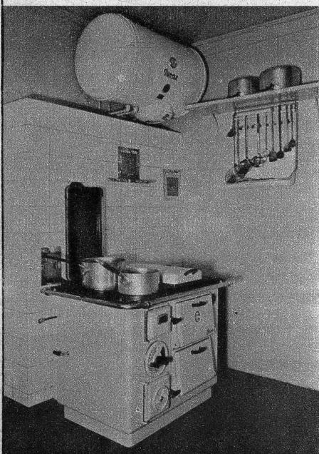
sauber wie ein elektrischer Herd. Der Wunsch jeder Hausfrau, eine ständige Heisswasserquelle in Küche und Badzimmer zu besitzen, geht in Erfüllung durch Anschluss eines Heisswasser-boilers an den Kochherd. Die Installationskosten sind rasch amortisiert, weil die Leistung der ganzen Kochherdanlage durch den Boiler-anchluss stark erhöht wird.
