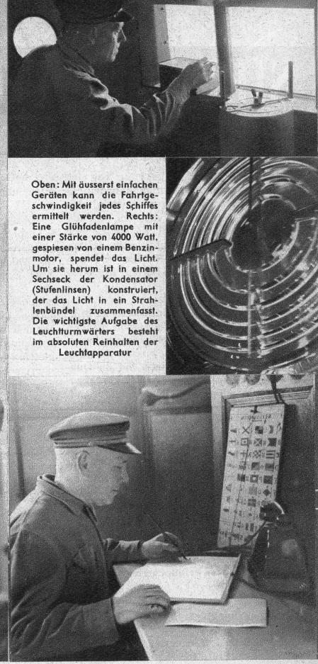
Oben: Mit äusserst einfachen Geräten kann die Fahrtgeschwindigkeit jedes Schiffes ermittelt werden. Rechts: Eine Glühlampe mit einer Stärke von 4000 Watt, gespiesen von einem Benzinmotor, spendet das Licht. Um sie herum ist in einem Sechseck der Kondensator (Stufenlinsen) konstruiert, der das Licht in ein Strahlenbündel zusammenfass. Die wichtigste Aufgabe des Leuchtturmwärters besteht im absoluten Reinhalten der Leuchtturmparatur
