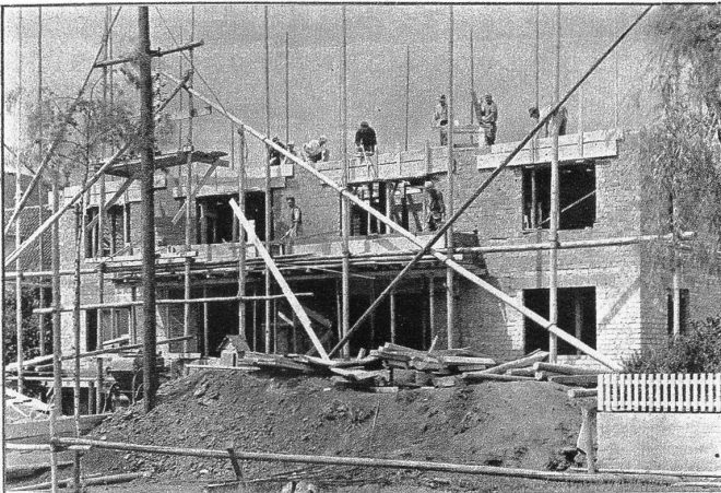
Ansicht einer Baustelle für ein Mehrfamilienhaus
