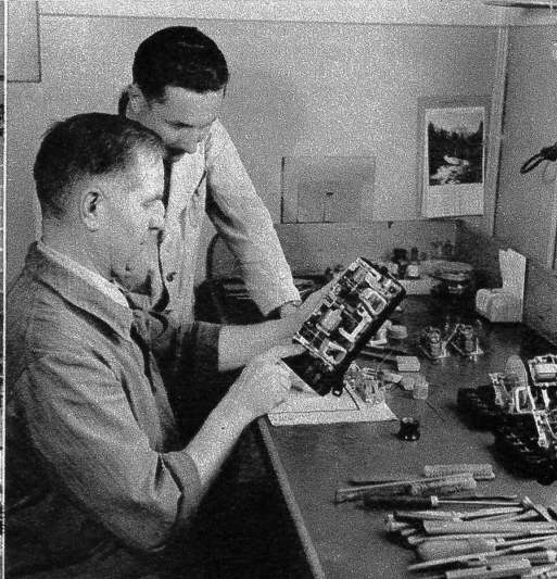
Der Vorarbeiter macht auf einen Fehler im Unterlager eines Zählers aufmerksam
