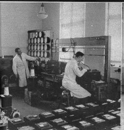
Prüfung eines reparierten Stromwandlers
