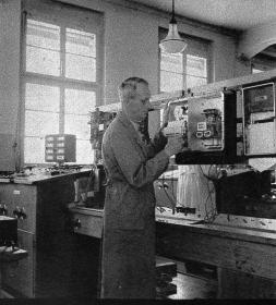
Hier werden Spezialzähler und Instrumente geeicht
