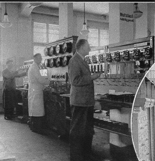
Der Eichmeister macht die Abnahmeprüfung einer Serie amtlich geprüfter Zähler
