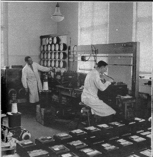
Prüfung eines reparierten Stromwandlers
