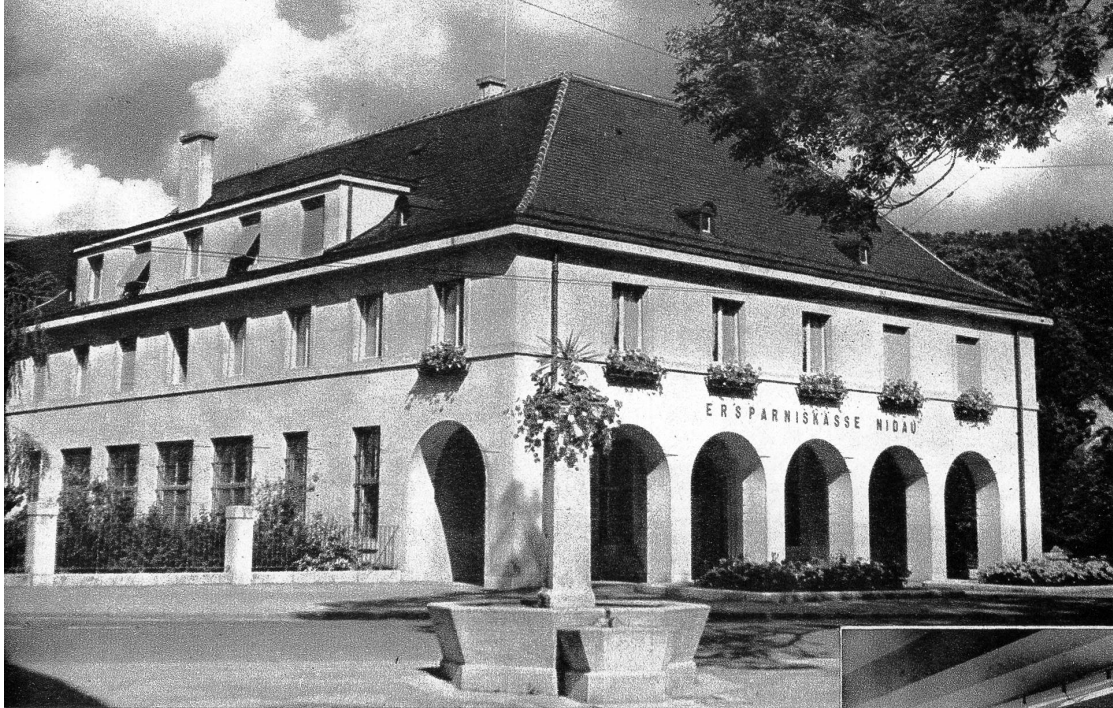
Ansicht der Ersparniskasse Nidau
