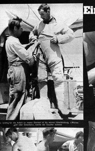
Arbeiter beim Bereitstellen der Tau-Dieser Kragen dient natürlich nicht zur blossen Zier, sondern dient dazu, den Helm daran festrausrüstung. Hier ist er gerade beim tschrauben des Luftschlauches am zumachen, er kann selbstverständlich nicht einfach mit Nadeln festgeheftet werden, sondern muss mit währschaften Schraubenmuttern mit aller Kraft festgeschraubt werden
