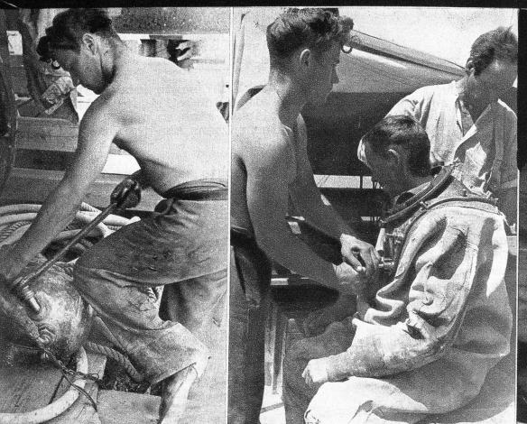
Ein Arbeiter beim Bereitstellen der Tauchausrüstung. Hier ist er gerade beim Festschrauben des Luftschaubes am Taucherhelm
