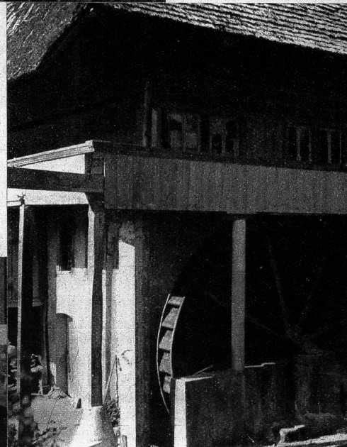
Ein zirka 40 Meter langer Holzkänel leitet das dem Dorfbach entnommene Wasser über die Laube auf der westlichen Seite des Gebäudes
