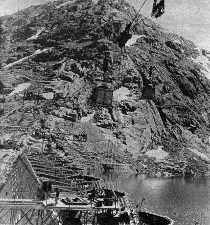
Das Betonieren der Dammkrone geschieht von einer schwappenden Hängebühne aus, die an Seilen quer über die Staumauer rollt
