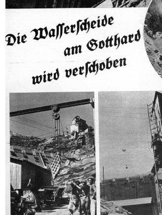
Steine zerkleinert, der Sand gesiebt, der Beton angerührt und zu den Arbeitsplätzen befördert
