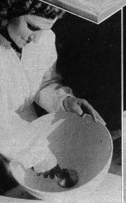
Einbau des Lagers in die Cartofont-Schale
