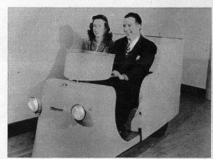
In Neuyork erblickte die «Motorette» das Licht der Welt. Das dreiräderige Fahrzeug ist vollständig aus Aluminium hergestellt und besitzt einen Zweizylinder-Motor, automatische Kupplung und Schaltung sowie einen elektrischen Starter. Die «Motorrette» verbraucht auf 130 Kilometer 4 Liter Benzin.
