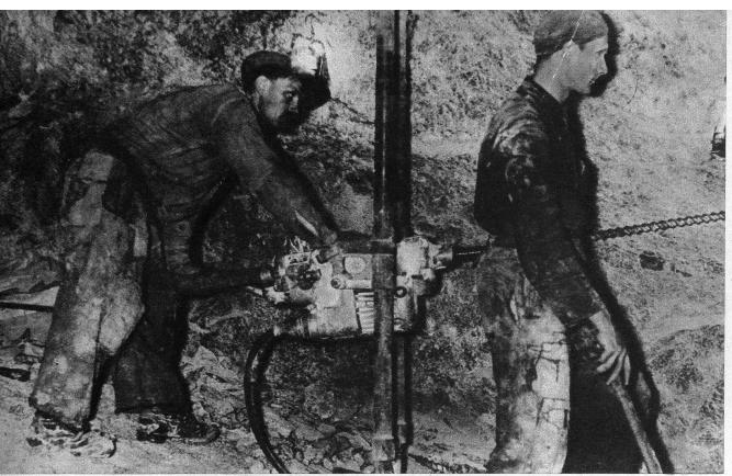
Links: Hauer bei der Erstellung von Bohrlöchern mit dem Pressluftbohrer. Genau wie beim Tunnelbau werden dann Sprengungenvollzogen
