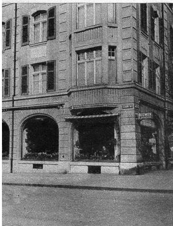
Aussenansicht des Blumengeschäftes Ecke Moserstrasse-Schläflistrasse
