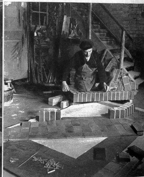
Das Erstellen eines Cheminées erfordert genaue Berechnung und peinliche Ausführung
