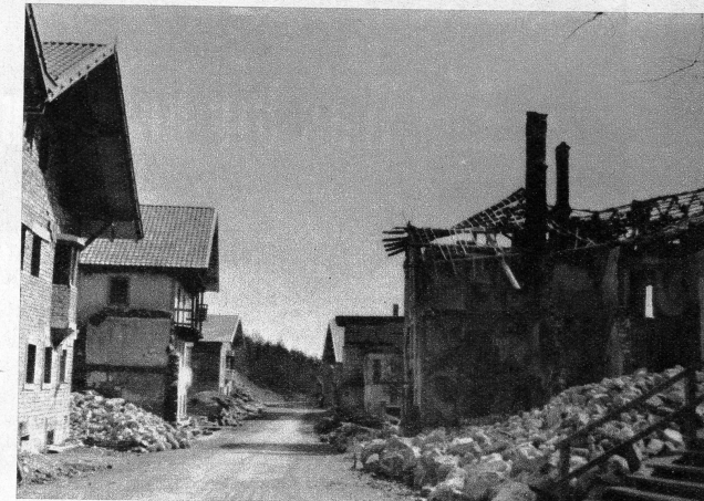
Die Dorfstrasse von Reith. Links die ersten wiederaufgebauten Häuser
