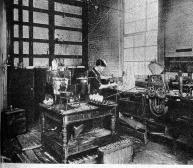
Eine frühe Ansicht des Galvanisierungsraumes in Edisons Laboin New Jersey. Elektrische Birnen werden auf einer Trockenbatterie ausprobiert
