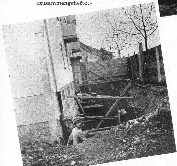
Mit schweren Eisenbalken werden die Häuser «zusammengeheftet»
