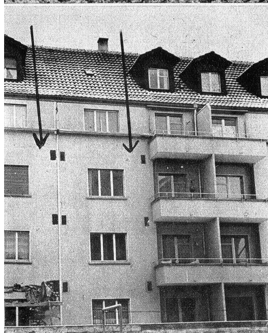
Mit schweren Eisenbalken werden die Häuser «zusammengeheftet»
