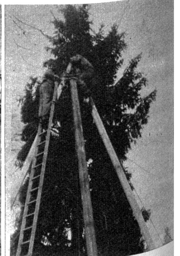
Mit einem Dreibock und einem Flaschenzug wurde die Tanne aufgezogen
