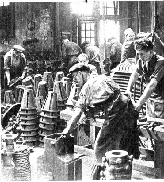
In der Kleinstück-Putzerei passiert der rohe Guss zuerst das Sandstrahl-Gebläse und wird dann mit Feilen, Pressluftmeisseln und Schleifmaschinen von den verbleibenden Unreinigkeiten, „Federn“ usw. befreit
